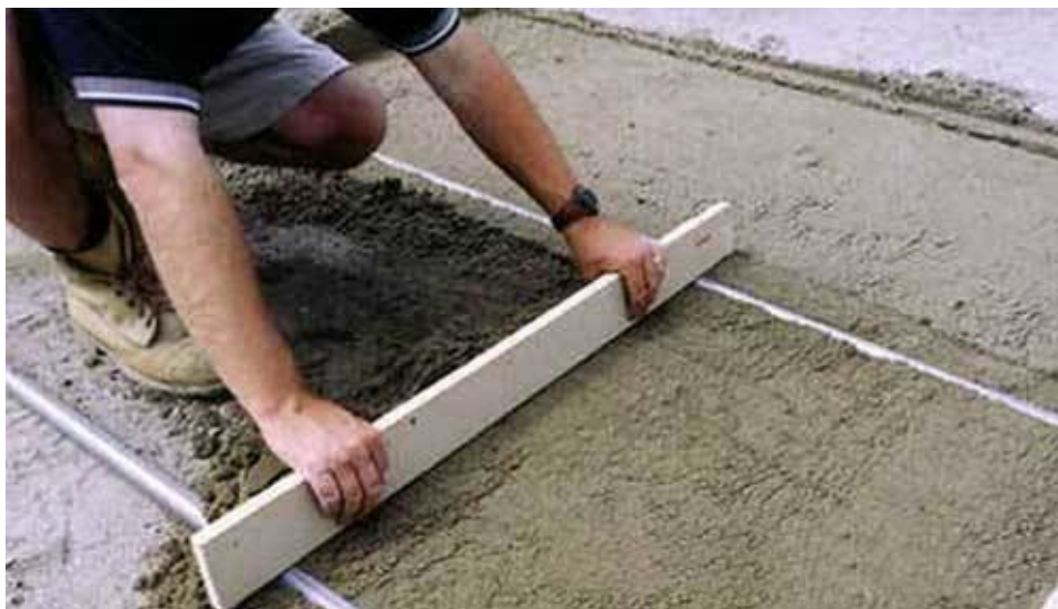
Стягивание полусухой стяжки
