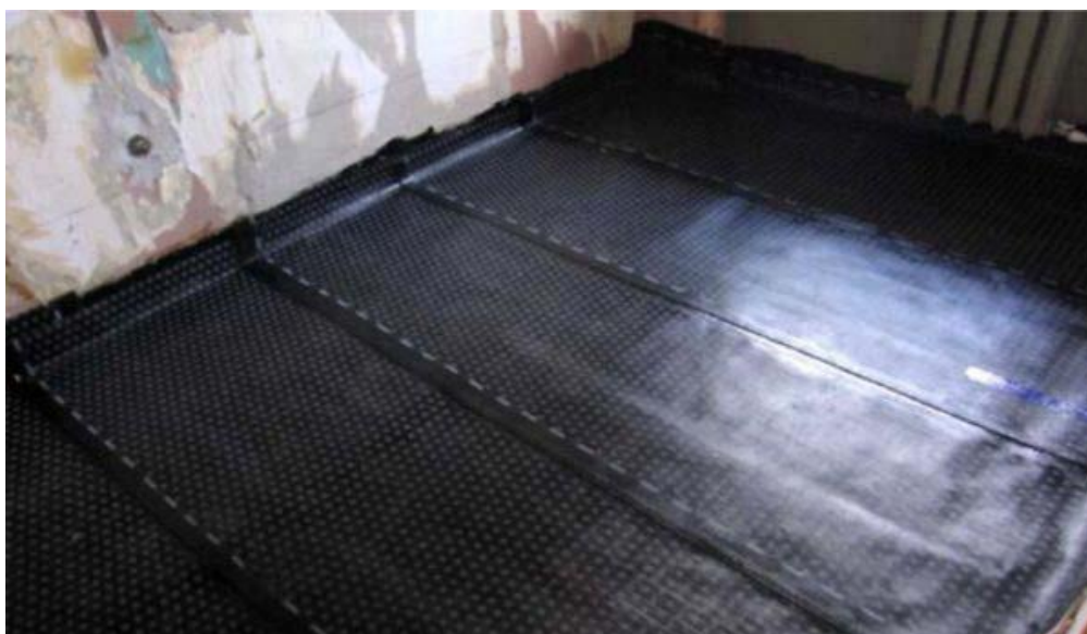
Настил гидроизоляционного материала
