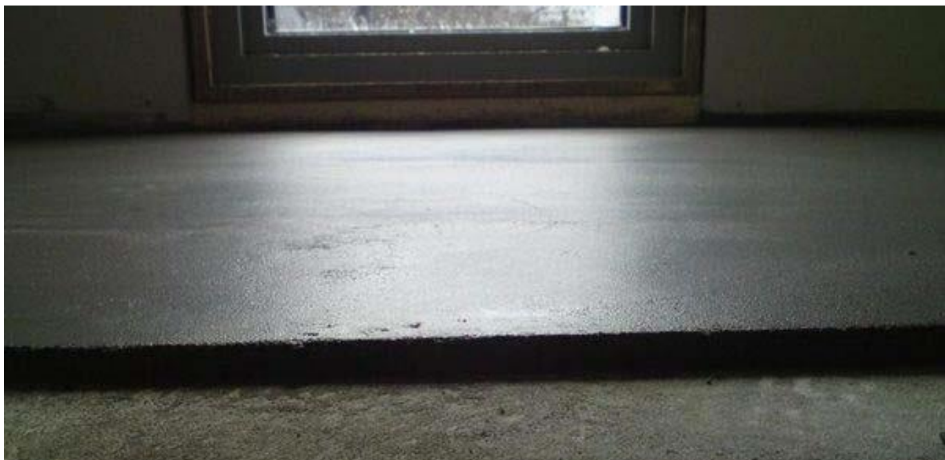
Готовая бетонная стяжка
