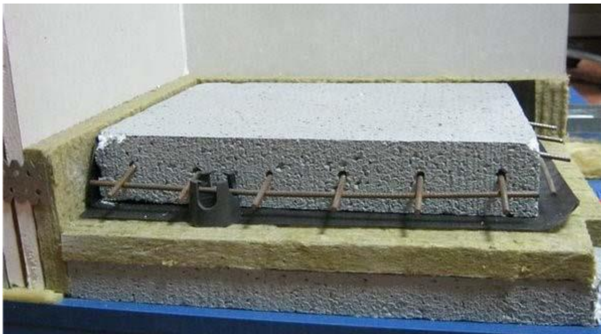
Армированная бетонная стяжка в разрезе
