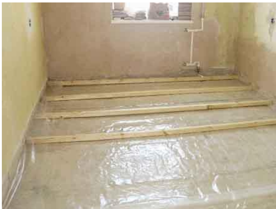
Укладка лаг на гидроизоляционную пленку
