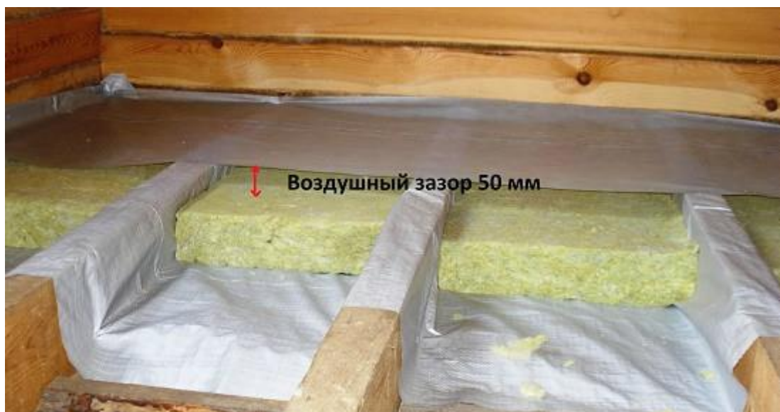
Закладка теплоизоляции между лагами
