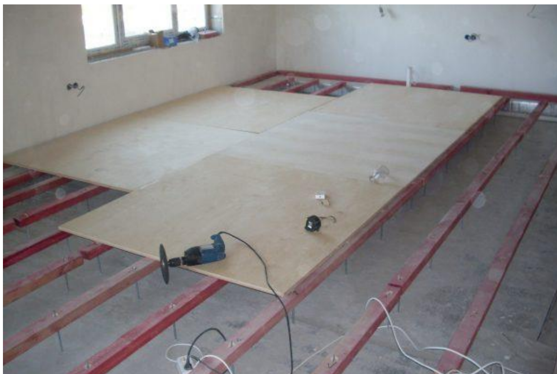
Фото фанерного пола на лагах
