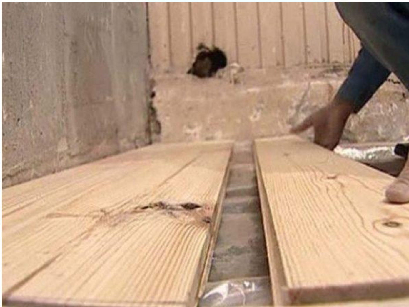
Укладка деревянного пола на лаги
