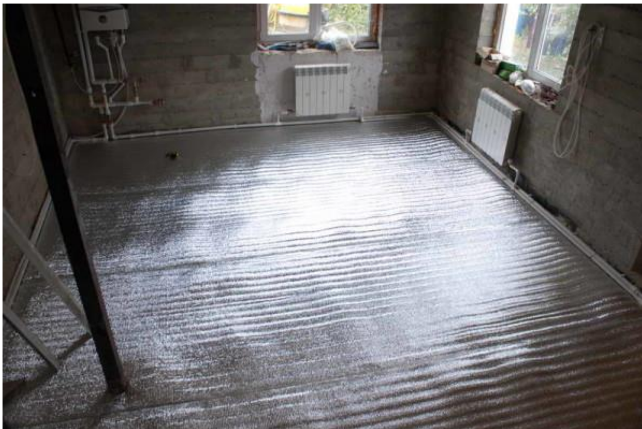
Пароизоляция (пенофол)
