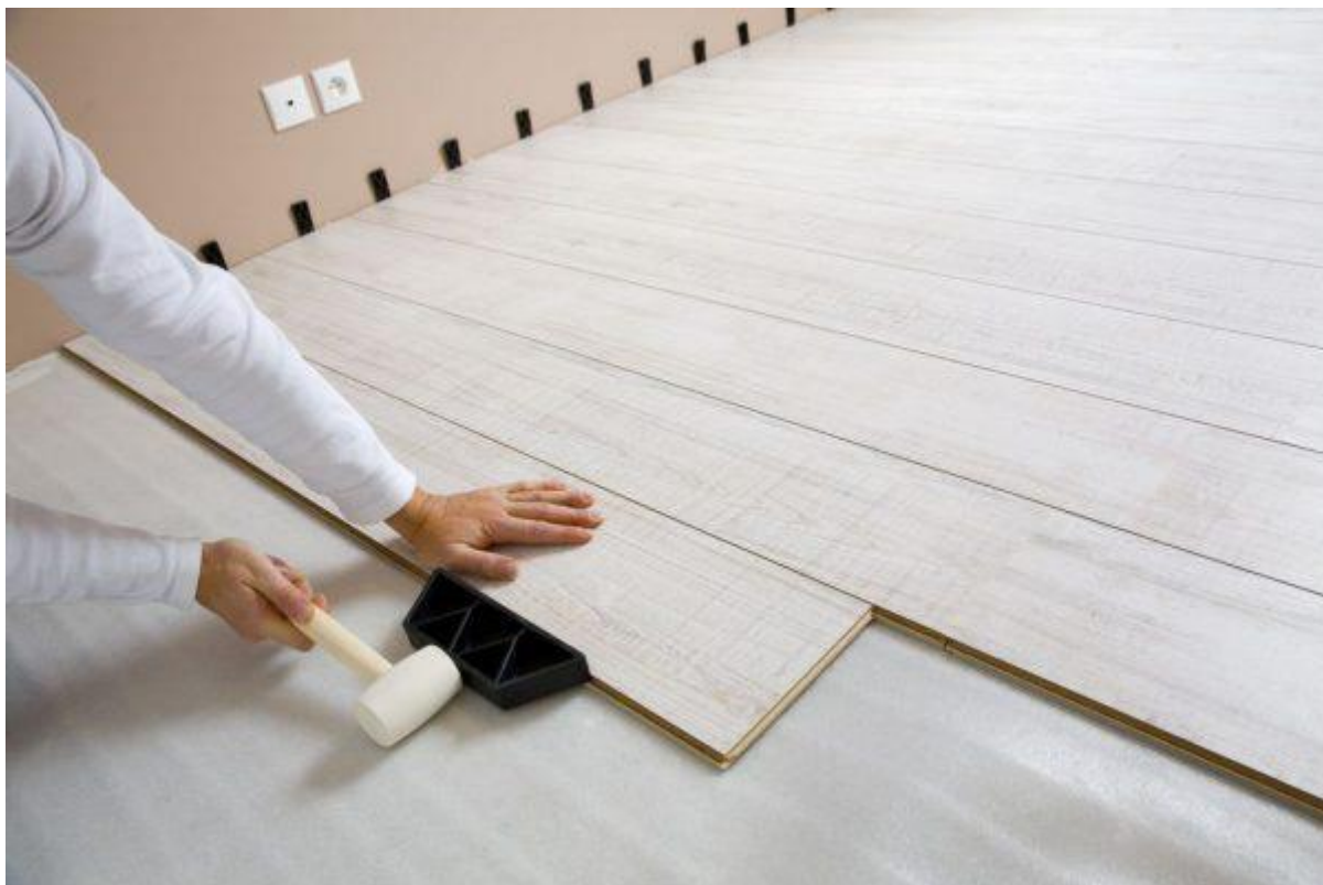
Укладка паркета на деревянный пол
