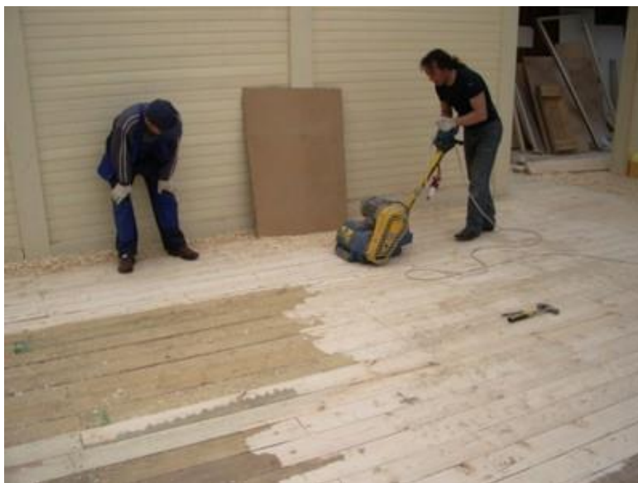
Проведение циклевки пола
