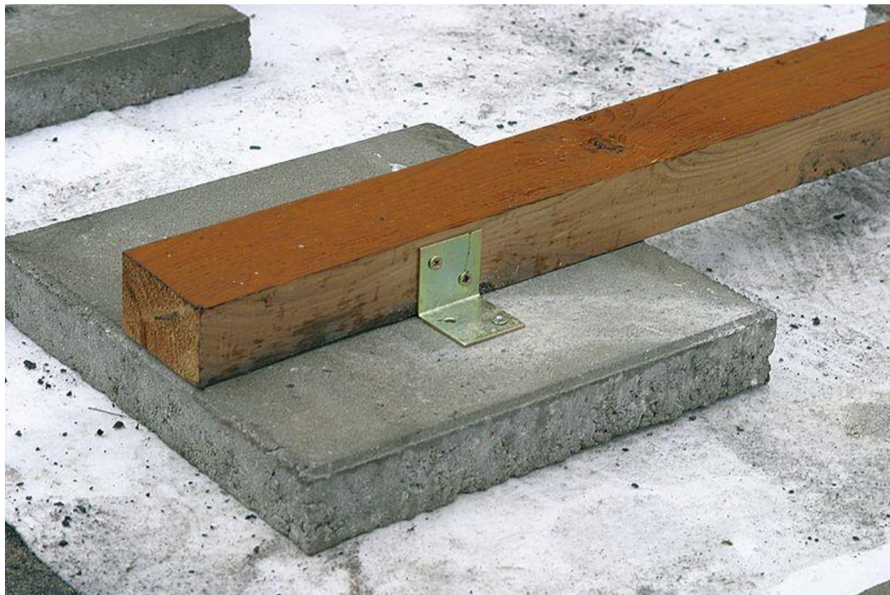
Укладка лаг на железобетонное основание
