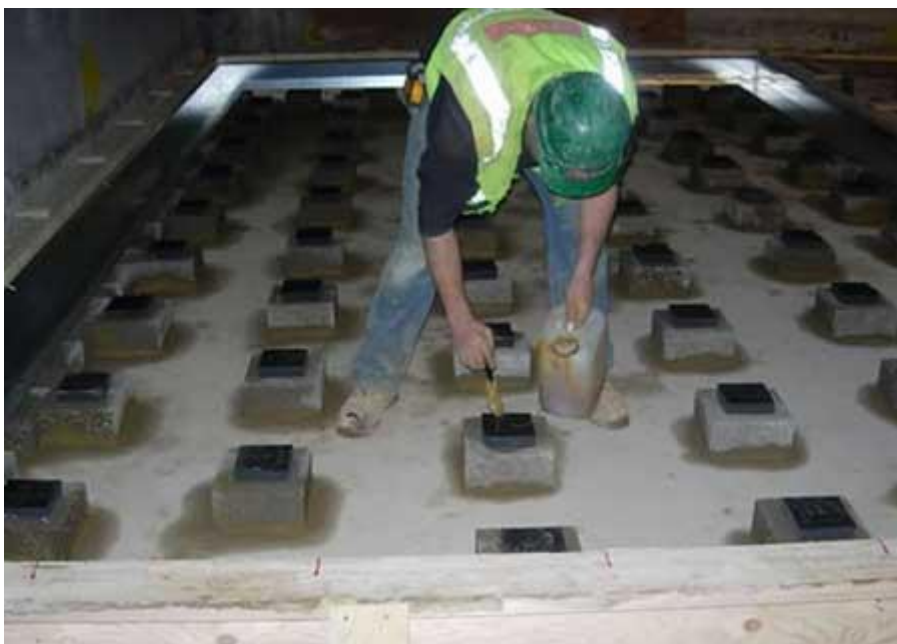
Основания для укладки лаг по грунту. Выполнение обмазочной гидроизоляции
