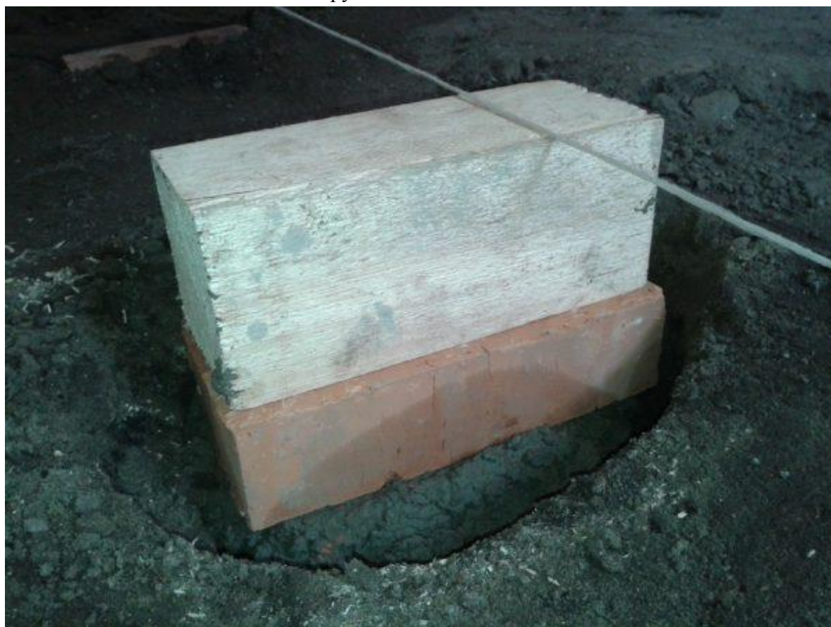
Основания для укладки лаг по грунту
