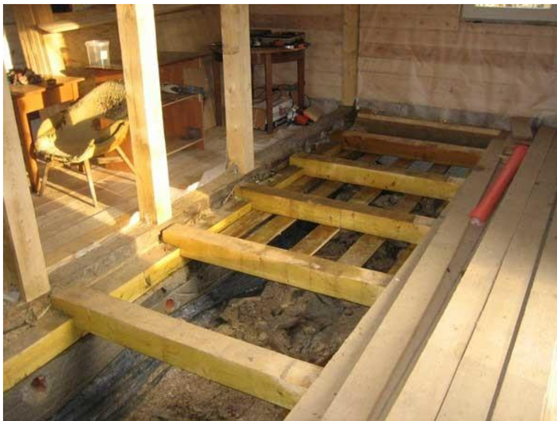
Укладка половой доски на лаги
